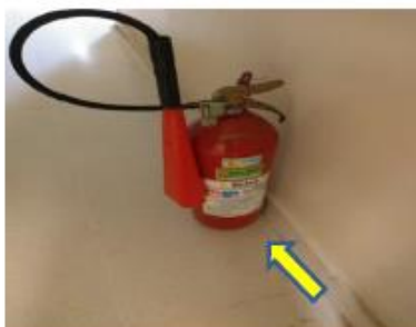
EXTINTOR CO2 06KG VENCIDO SOB O PISO, NECESSITA DE MANUTENÇÃO E INSTALAÇÃO
