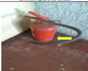
EXTINTOR PQS BC 04KG VENCIDO E NECESSITANDO DE INSTALAÇÃO
