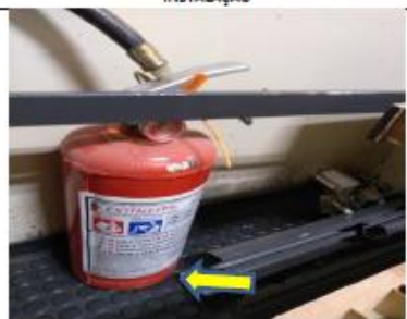
EXTINTOR PQS BC 06KG VENCIDO SOB O PISO, NECESSITA DE MANUTENÇÃO E INSTALAÇÃO
