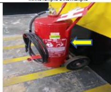
EXTINTOR PQS BC 50KG VENCIDO NECESSITA DE MANUTENÇÃO
