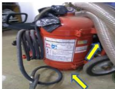
EXTINTOR PQS BC 50KG VENCIDO E OBSTRUÍDO
