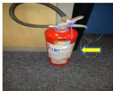
EXTINTOR PQS BC 06KG VENCIDO E NECESSITANDO DE INSTALAÇÃO
