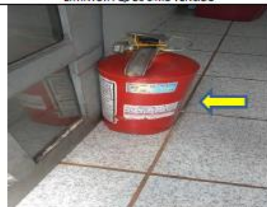
EXTINTOR PQS BC 04KG VENCIDO E NECESSITANDO DE INSTALAÇÃO
