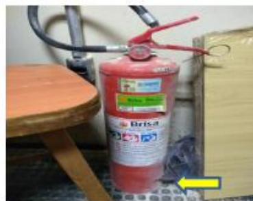
EXTINTOR PQS ABC 06KG VENCIDO E ACIONADO SOB O PISO, NECESSITA MANUTENÇÃO E INSTALAÇÃO
