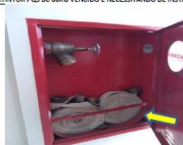
MANGUEIRAS COM TESTE VENCIDO, ESGUICHO JATO SÓLIDO E FALTA CHAVE STORZ
