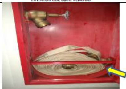
MANGUEIRAS COM TESTE VENCIDO, ESGUICHO JATO SÓLIDO E FALTA CHAVE STORZ
