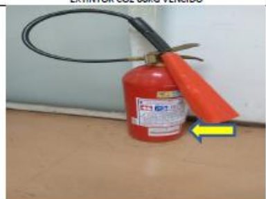
EXTINTOR CO2 06KG VENCIDO E NECESSITANDO DE INSTALAÇÃO
