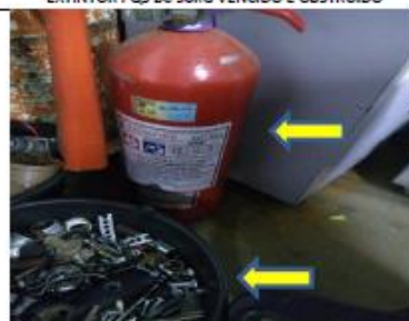
EXTINTOR CO2 06KG VENCIDO SOB O PISO E OBSTRUÍDO
